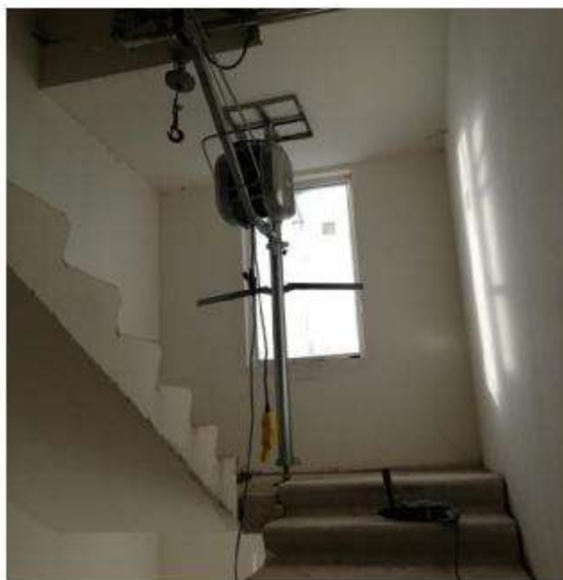
Схема крепления рабочей лебедки
